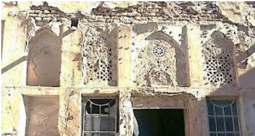
شكل ( رقم ١ ) يوضح حالة تشوه المبنى عند صيانتة بطريقة غير علمية
