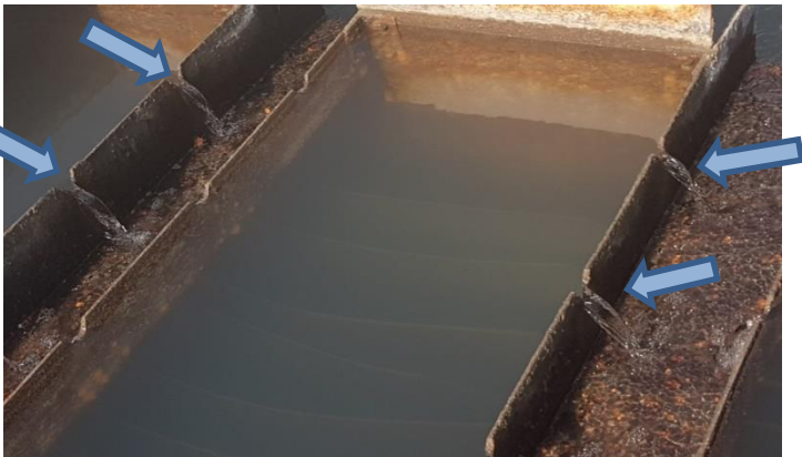
شكل 14: شكل يوضح انعدام العكورة في قنوات تجميع المياه الخارجة من حوض الترسيب
