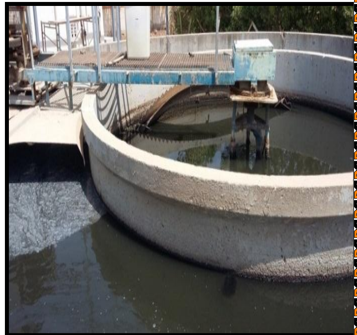
صورة رقم (15) تبين حوض المعالجة والأذرع المعطلة للمعالجة
