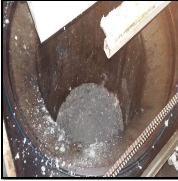
صورة رقم (13) تبين مرحلة الشرم للنفايات الطبية الصلبة وتكوين العجينة التي تتعرض للتعقيم في مواد خاصة وبدرجات حرارة عالية من البخار.
